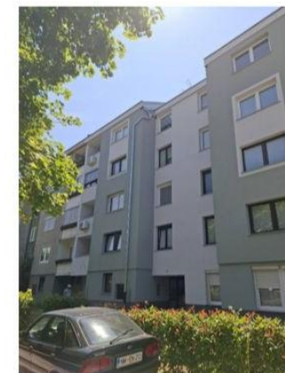
Slika: Fasada po prenovi
