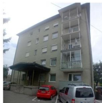
Slika: Fasada pred prenovo
