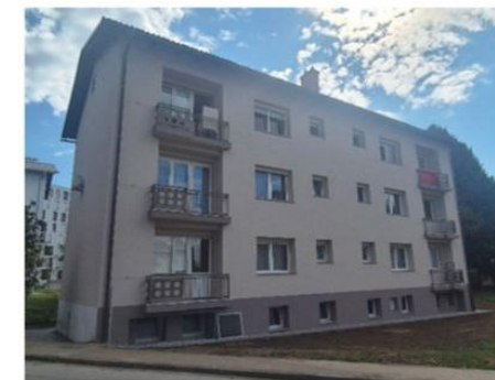
Slika: Fasada po prenovi
