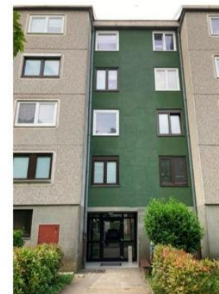
Slika: Fasada pred prenovo
