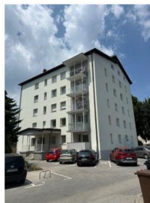
Slika: Fasada po prenovi
